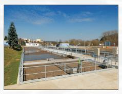
V letech 2012 - 2014 proběhla intenzifikace a rozšíření čistírny odpadních vod Benešov s navrhovanou biologickou kapacitou 53 750 EO. Technologická linka čistírny odpadních vod je navržena jako mechanicko-biologický stupeň s kalovým a plynovým hospodářstvím a chemickým srážením fosforu. Koncepce čistírny je řešena jako systém pro odstraňování uhlíkatého znečištění, biologickou nitrifikaci a denitrifikaci a chemickou eliminaci sloučenin fosforu.
